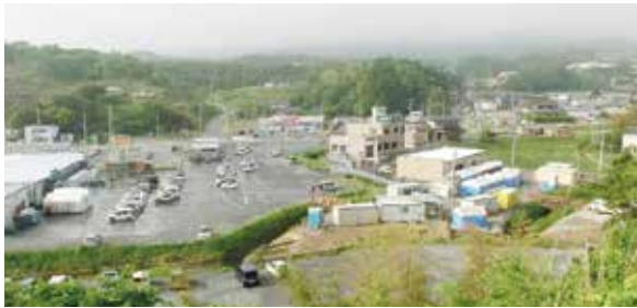
竹駒地区。中央右側が未来商店街コンテナエリア
