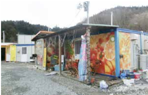
未来商店街コンテナエリア（2012年）。その後歩行者路を整備
